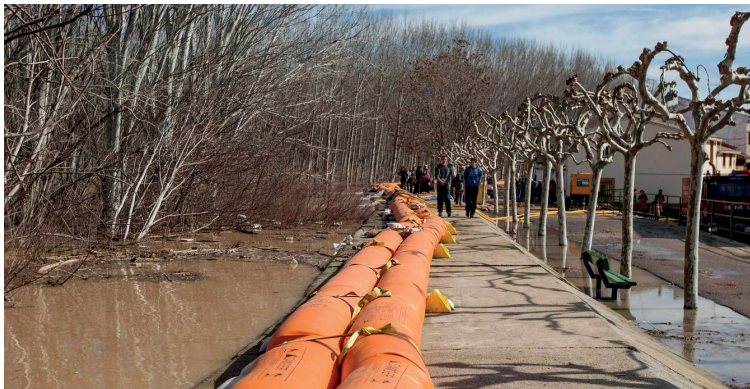
Figura 18. Barreras anti-inundación, Cabañas de Ebro, Zaragoza, 2015.
