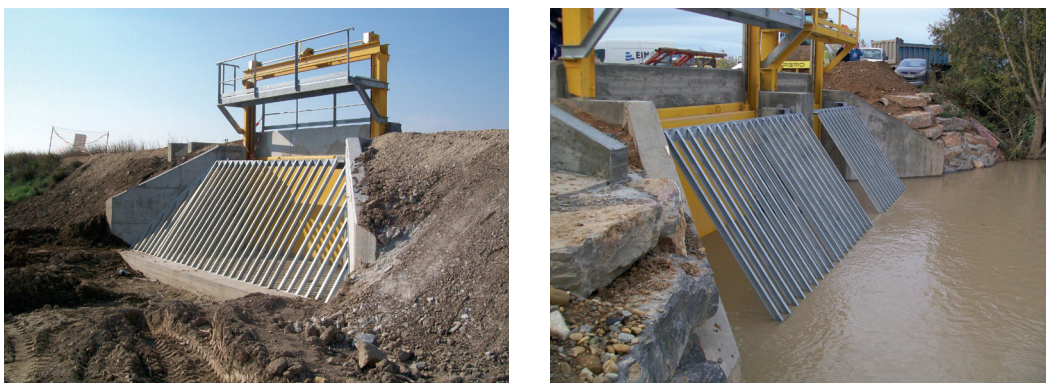
Figura 31. Zona de inundación controlada. Compuertas. Pina de Ebro (izq.) y Novillas (dcha.).
