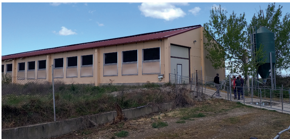
Figura 4. Nave de cebo elevada sobre el terreno en Nuez de Ebro.
