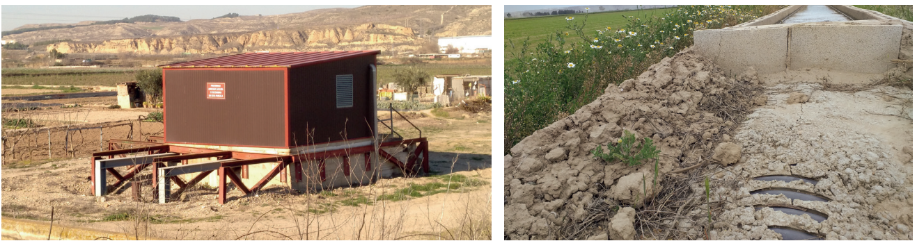
Figura 21. Pozo sobreelevado (Azagra) y acequia protegida y entubada (Alfajarín).
