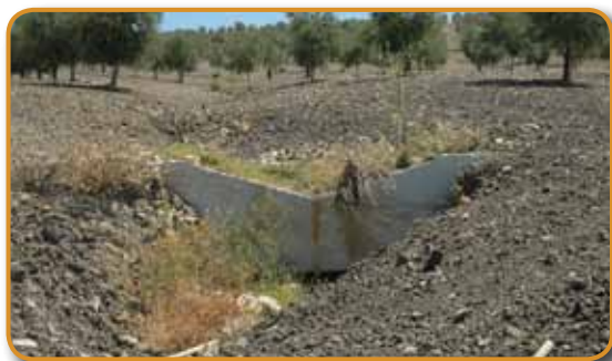
Figura 9. Gavión para control de erosión en cárcava
