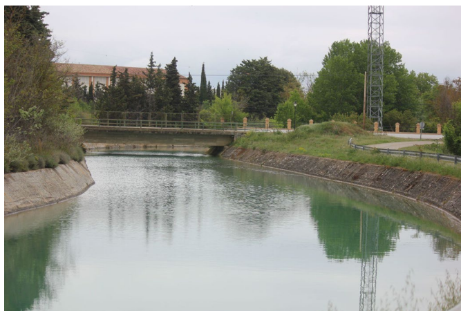
Figura 9. Canal de Bárdenas en Sádaba. ( Fuente: Elaboración propia).
